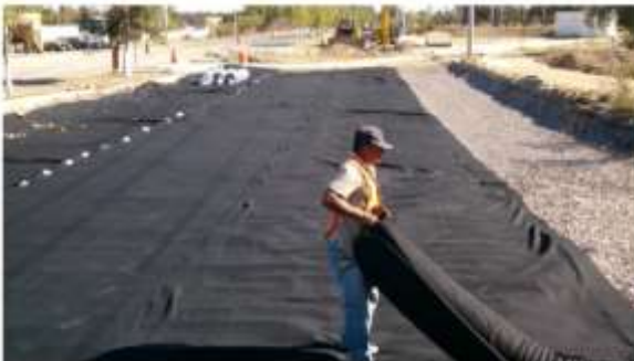
Imagen ilustrativa de la colocación del geotextil sobre la geomalla
