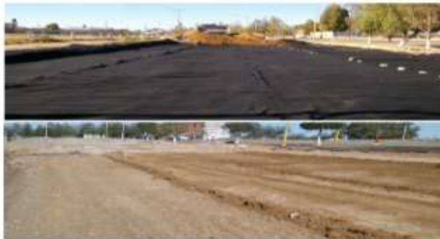
Imagen ilustrativa de la construcción de la sub base.
