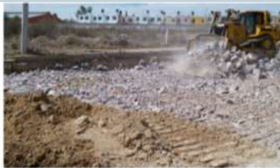
Imagen ilustrativa de la conformación del pedraplén en la zona de moleda de la falla
