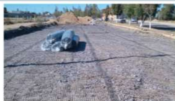
Imagen ilustrativa de la colocación de la geomalla sobre el pedraplén.
